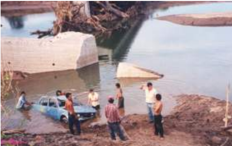
Eingestürzte Brücke nach dem verheerenden Hurrikan »Mitch« 1998
