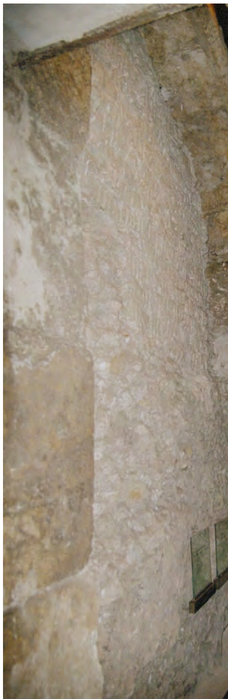
Abb. 9 Das zubetonierte Warren-Tor im Westmauer Tunnel
