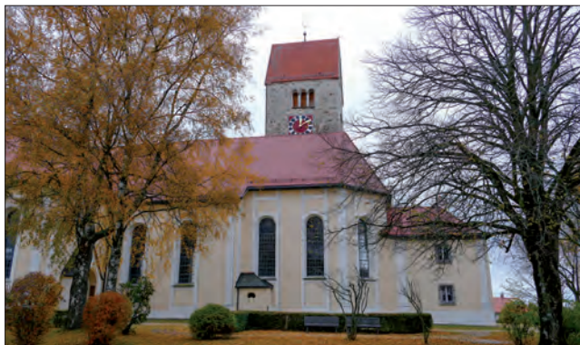
Kirche Wiggensbach November 2014 Foto: Walter Mauerhofer
